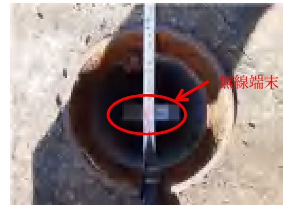
無線端末設置状況 (地下30cm程度に設置)
